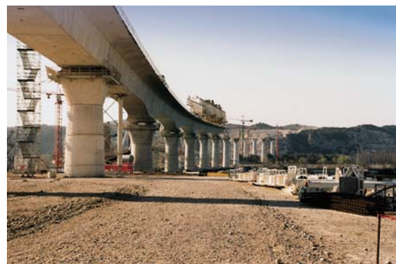
Les Viaducs sur le Rhône, France T.G.V. Méditerranée - Lot 2H, 1997 – 1998 26 pot bearings, vertical loads up to 43,000kN
